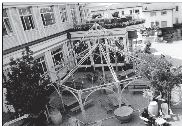
Pagodenzelt: Anordnung der Gemeinde Stallikon missachtet. Das Traggerüst ist immer noch fix montiert.
